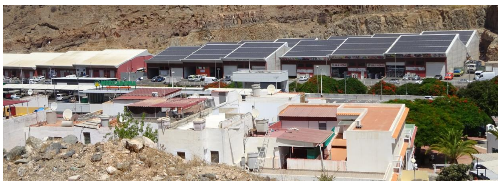
Ilustración 23. Imagen de los establecimientos comerciales con tipología edificatoria industrial. Fuente: aportación propia.
