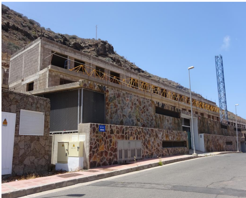
Ilustración 12. Obras constructivas al sur de la Parcela A5. Fuente propia.
